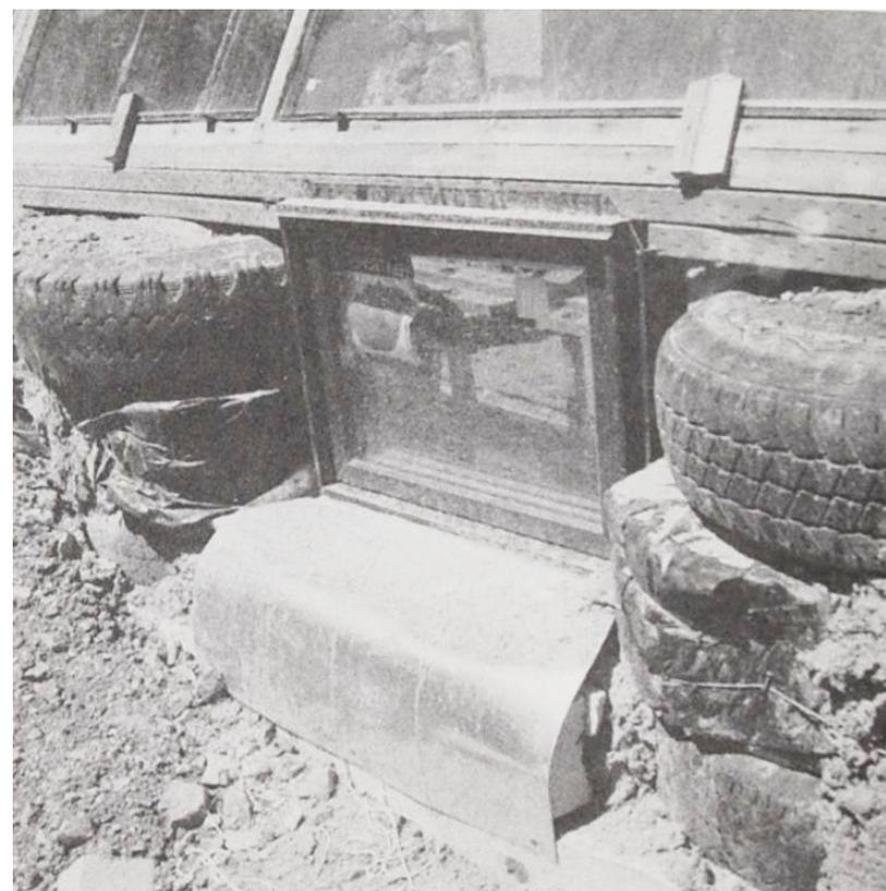
Esto rompe de alguna manera la integridad estructural de la pared, por lo que recomendamos relleno de cemento y latas a ambos lados de la pared en lugar del relleno normal de barro y latas que se usa cuando la pared no se interrumpe.
